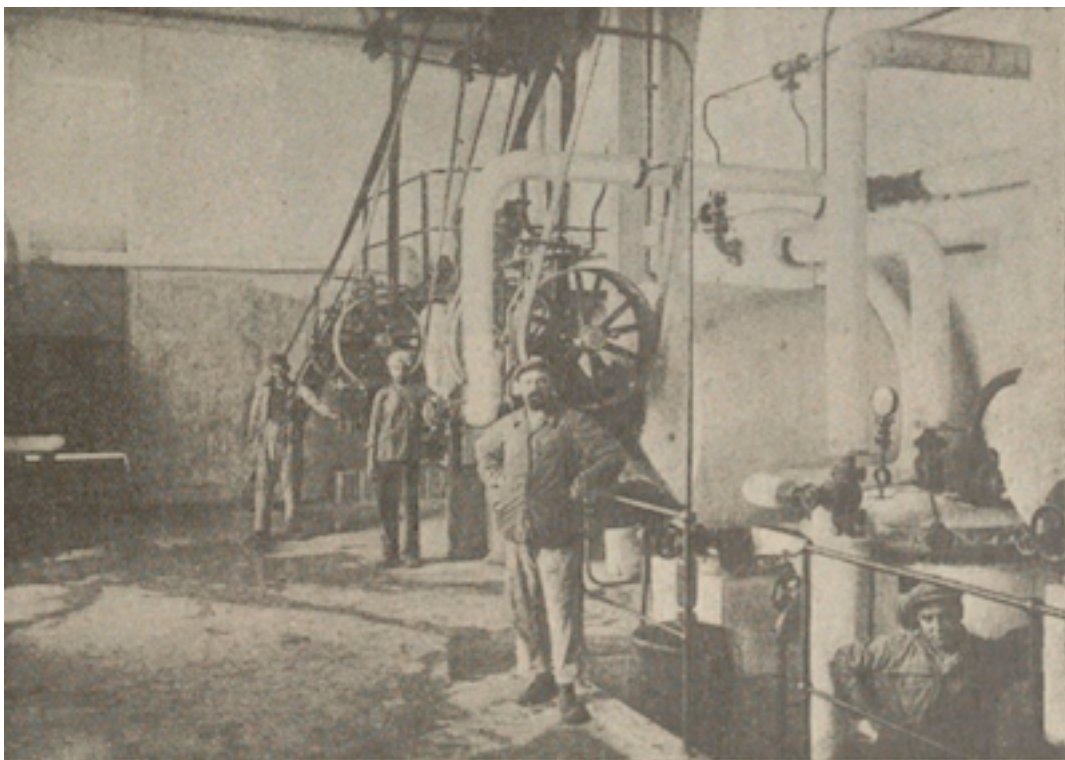
Fig. 30. — Appareils du clos d'équarrissage.
