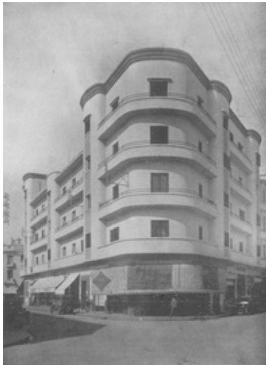
Immeuble Benallal [ou Benalal], avenue du Général-Drude et rue Guynemer (architectes : MM. Suraqui)
