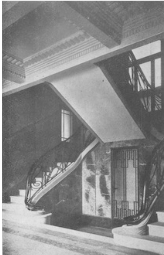
La cage de l'escalier est revêtue de marbre ; on remarquera la ferronnerie de la porte de l'ascenseur (Architecte : M. Greslin)
