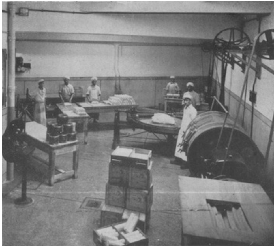
La beurrerie, vaste local clair et aéré, aux murs et sol revêtus de mosaïque, est équipée selon la technique la plus moderne pour traiter mécaniquement le beurre « Val d'Or » dans les meilleures conditions d'hygiène et de propreté.
