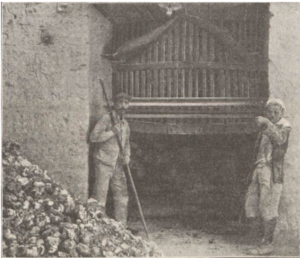
Fig. 6. — Vue du bas d'un four montrant l'extraction du ciment.
