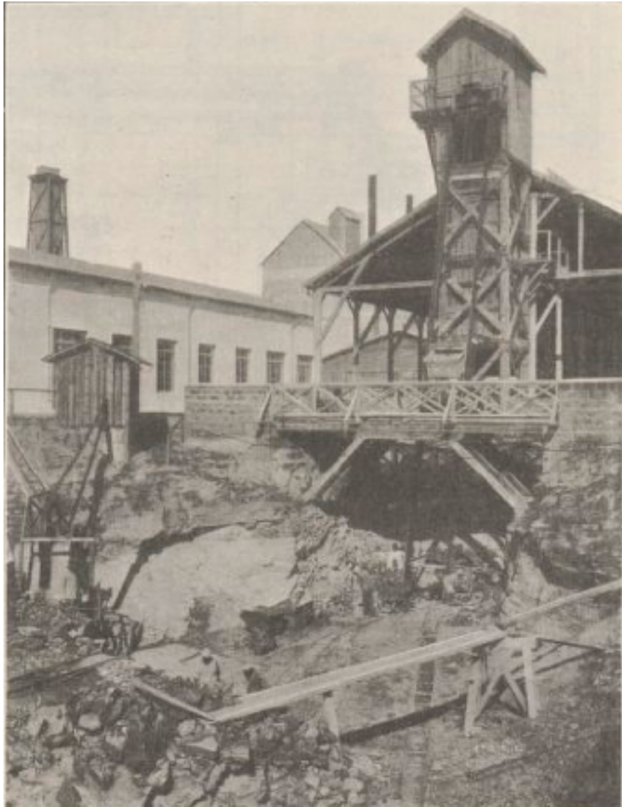
Fig. 9. — Entrée de la carrière et benne basculante automatique.
