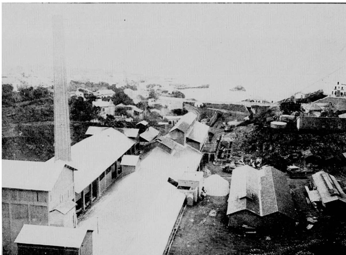
Vue générale de l'usine des Chaux et ciments de la Pointe-Pescade
