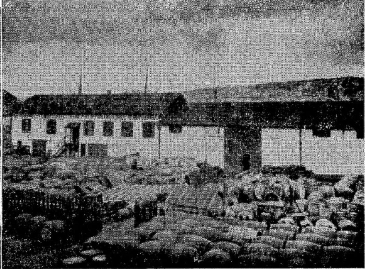
LES HANGARS DE LA SOCIÉTÉ COMMERCIALE D'ACCONAGE À ALGER
