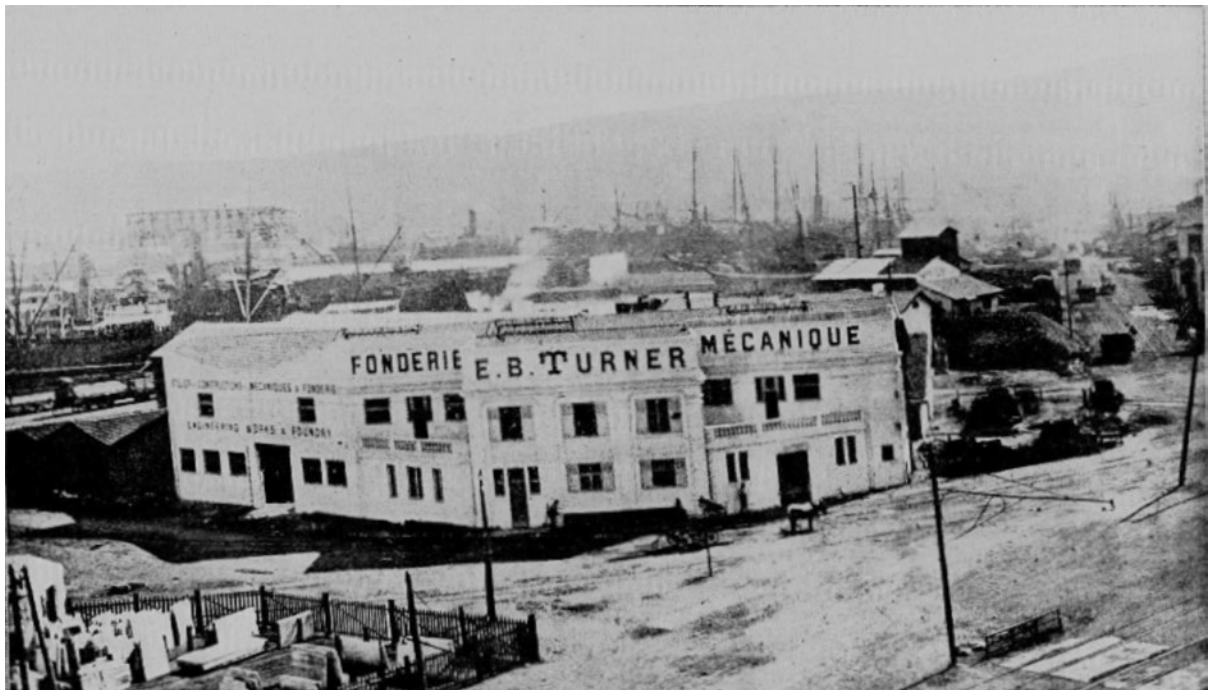
Vue générale de la fonderie Turner
