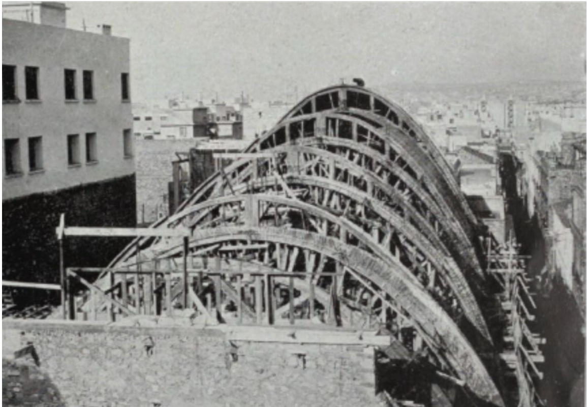
Une phase de la construction de la couverture
