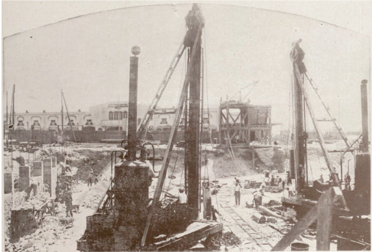
ASPECT DU CHANTIER EN AVRIL 1929. — Les fondations sur pieux en béton armé (système Frankignoul) ont été menées jusqu'à près de 5 mètres de profondeur.
