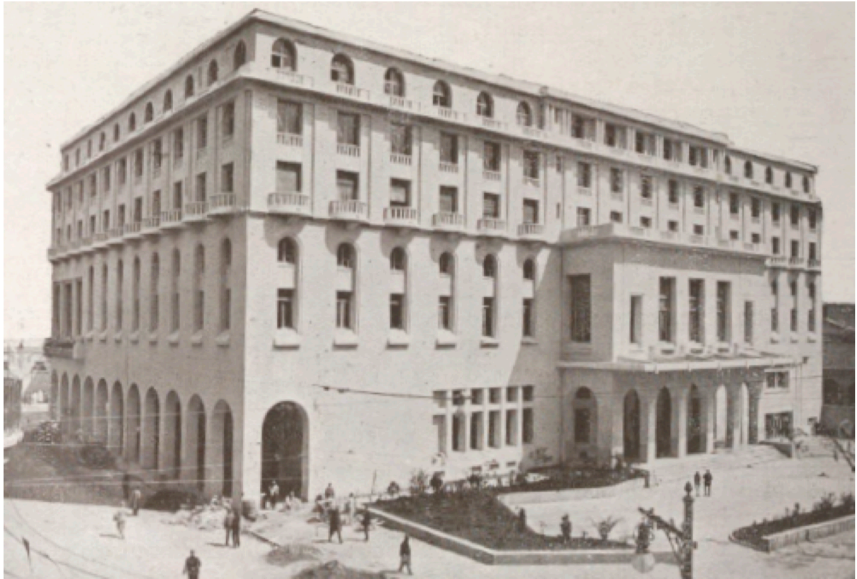
LA FAÇADE SUR LE JARDIN. — Des volumes sous la lumière, pour citer une expression de M. Le Corbusier. Le jeu des ombres met bien en valeur le relief de cette façade, dont on aurait pu craindre qu'elle ne fut massive à l'excès et qui reste simplement monumentale. Le portique à arcades précède l'entrée de l'hôtel ; au-dessus, les grandes baies de la salle de boule ; à côté, l'entrée du théâtre. Un petit jardin sépare le casino de la rue de Constantine. Photo Eichacker [447]
