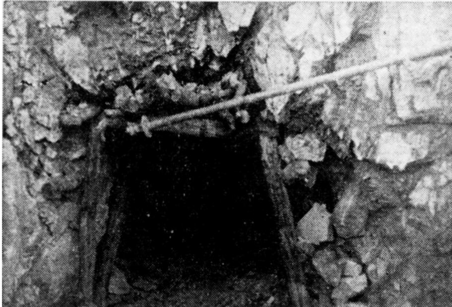
Le gisement se trouve dans une cassure longue de deux à trois kilomètres, dans un terrain disloqué et broyé, ainsi qu'il apparaît à l'entrée de cette galerie de recherches. Le passage a dû être boisé pour parer aux dangers d'éboulement. (Photo Ratel)
