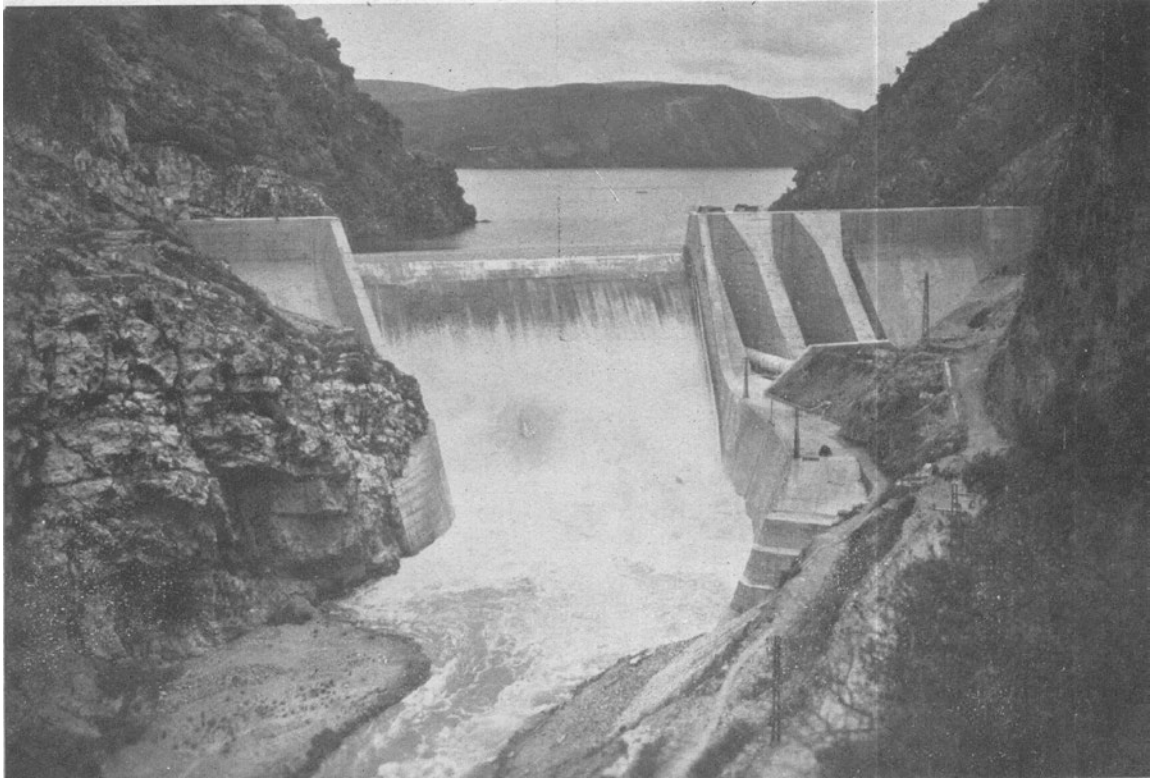
Barrage de l'oued Beth terminé. Crue du 19 mai 1936
