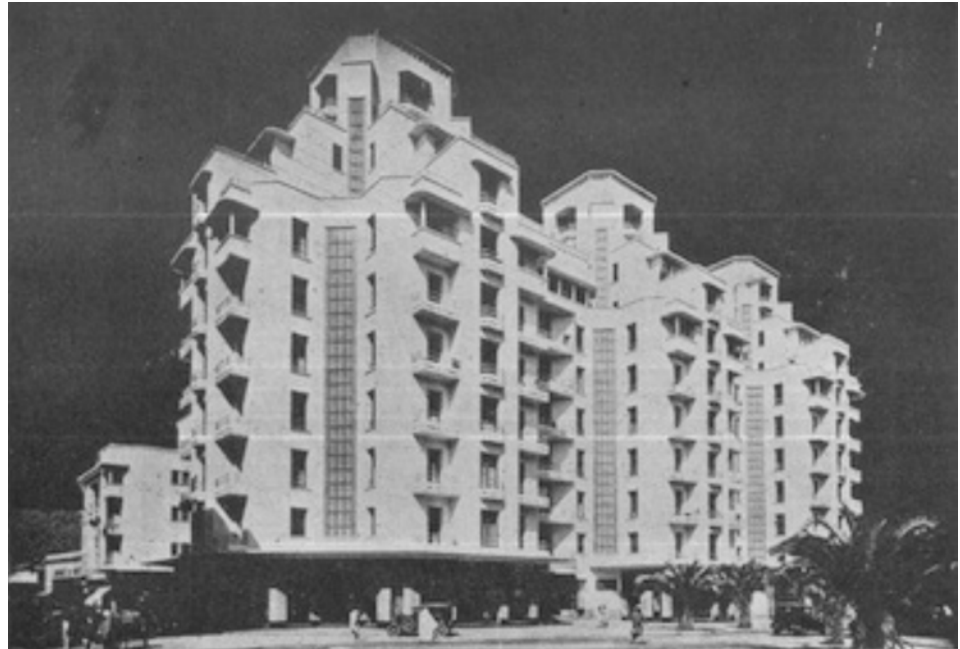
Immeuble Assayag. — 2 brûleurs CAT
