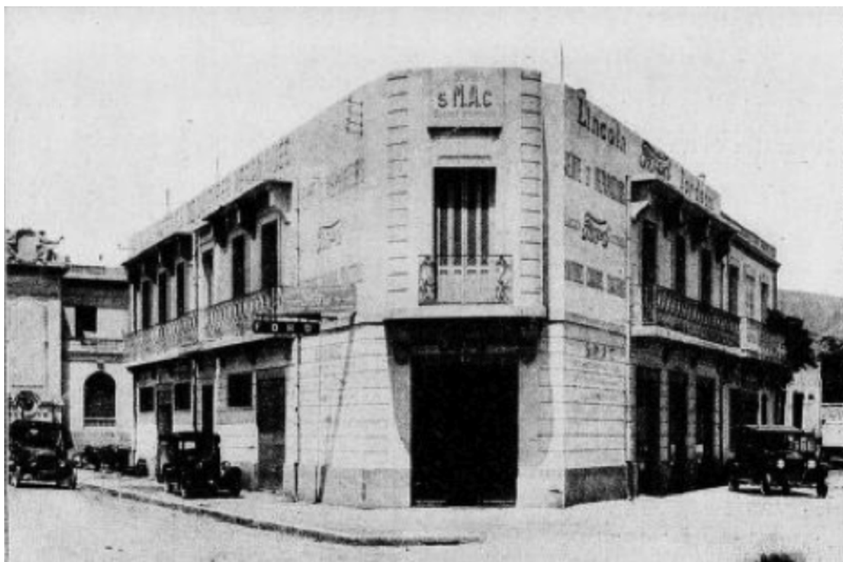
Vue extérieure de la S. M. A. C.
