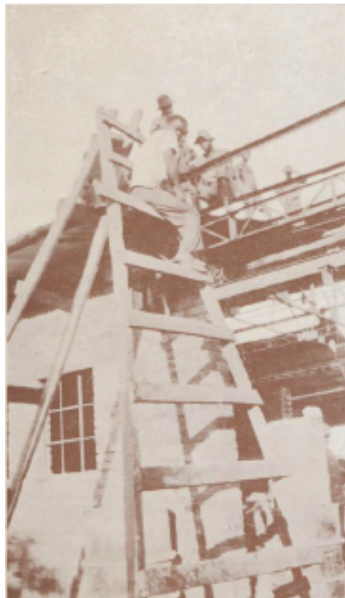
Mossaka. Construction d'une usine.
