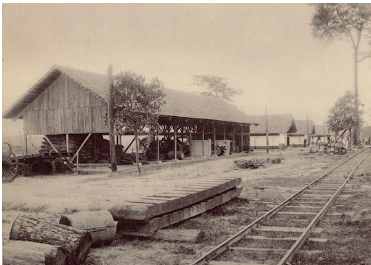
Planche 16. — Village de coolies desservi par le chemin de fer
