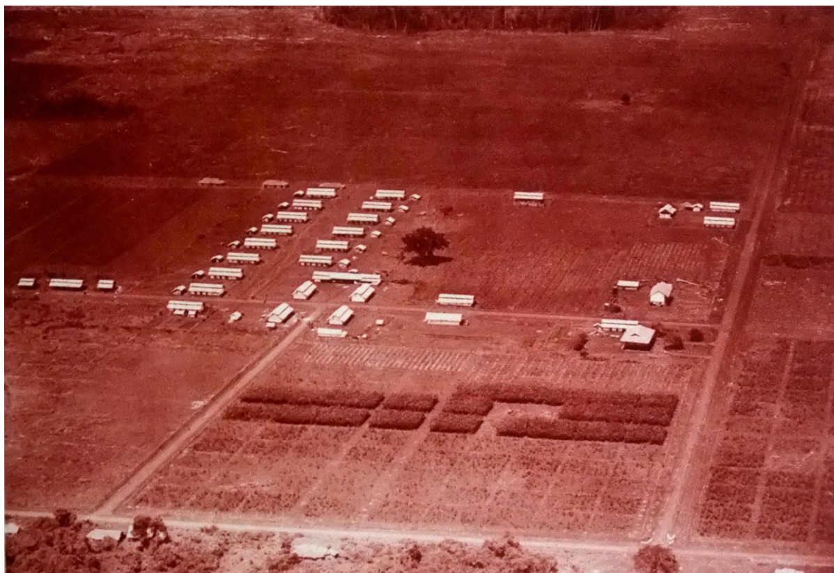
Campement des coolies, vus du Sud. Décembre 1929. Pl. 26
