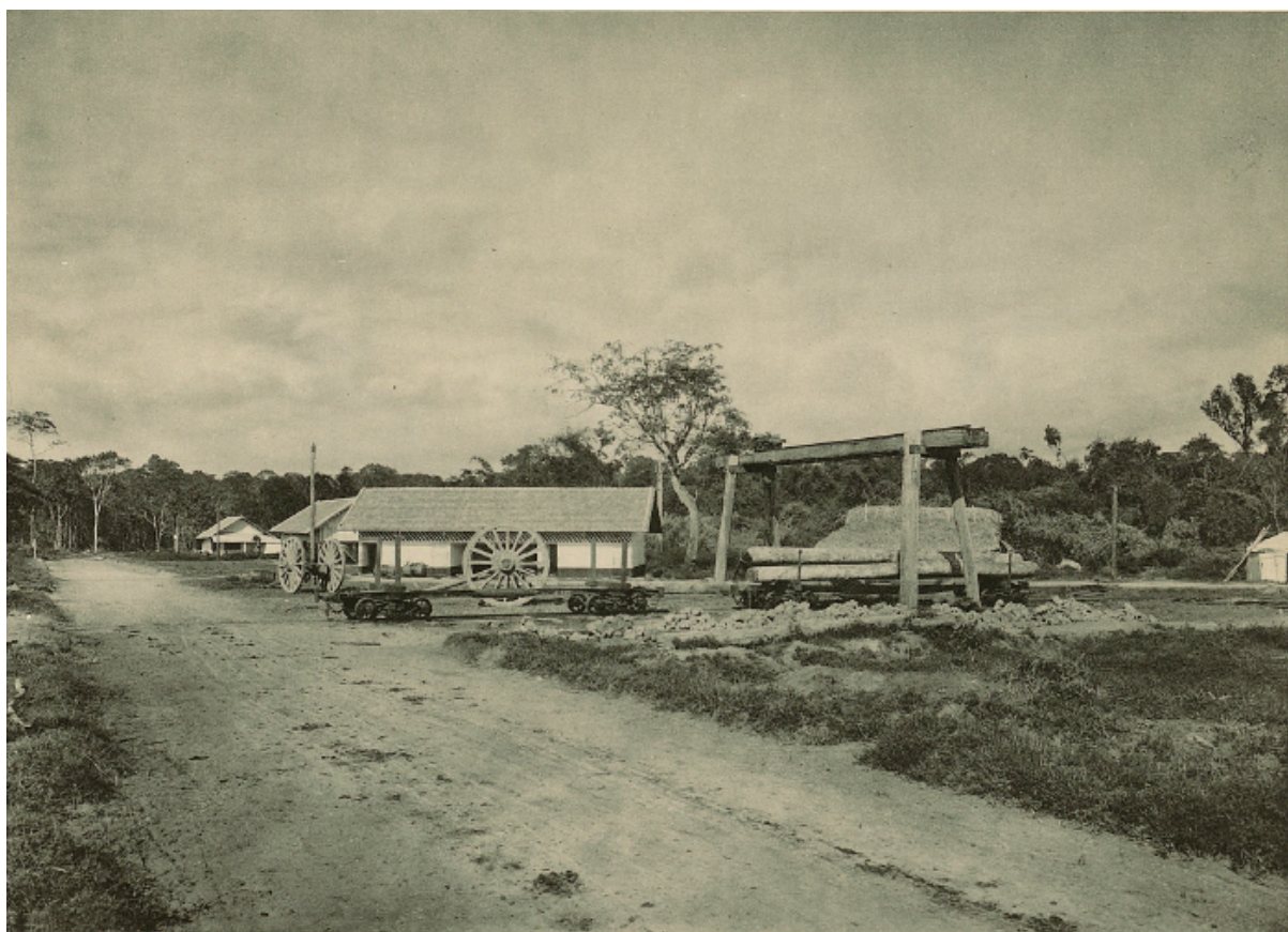
Planche 17. — La gare de Trangbom
