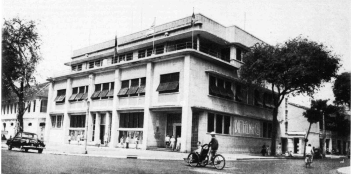
Installation dans les anciens locaux de Diethelm , 29, quai de Belgique
