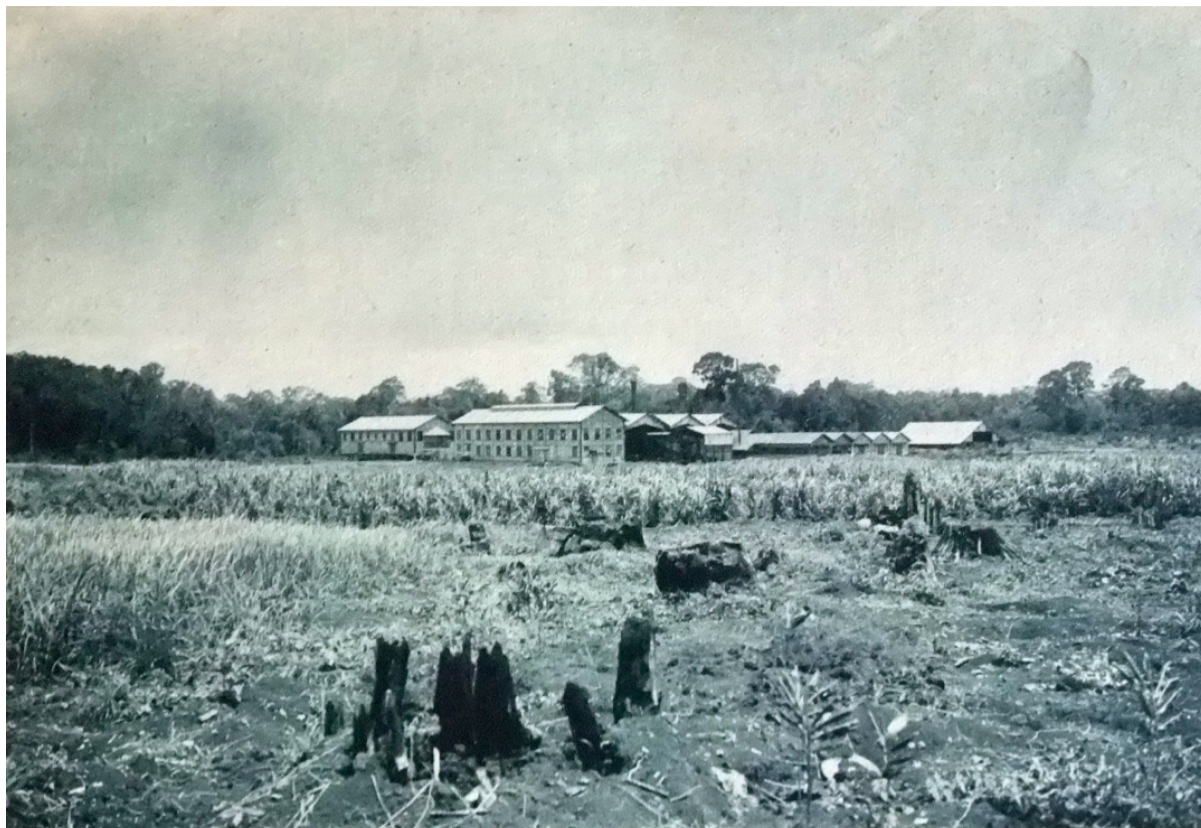
Ensemble des bâtiments de la sucrerie ( Annuaire du Syndicat des planteurs de caoutchouc de l'Indochine , 1931, pl. 7)
