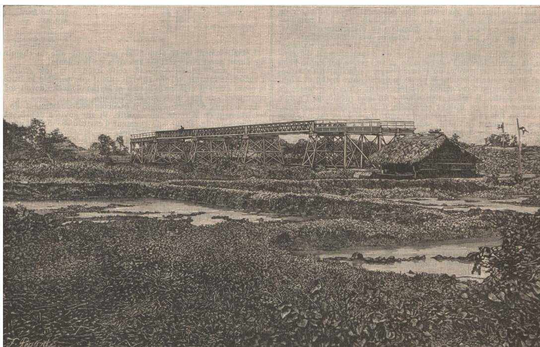
Construction du pont métallique de Binh-Dien, sur l'arroyo de Ben-Luc, en Cochinchine. (3 travées de 21,60 m. et 4 travées de rive de 8,10 m. (gravure de F. Pégard, d'après une photographie)
