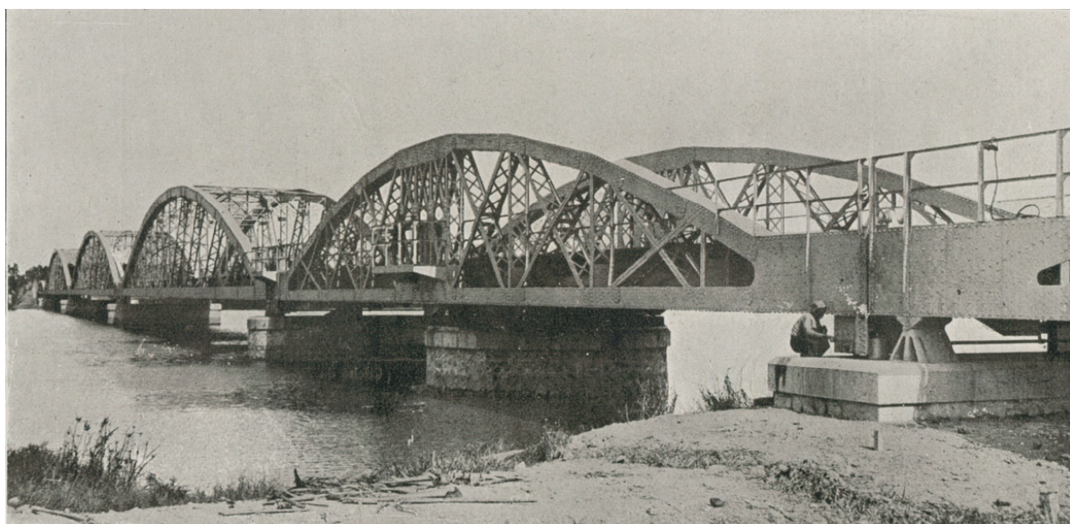
Chemins de fer de la Cochinchine et du Sud-Annam Le pont de Binh-Loï, sur la rivière de Saïgon, construit par la Société de Levallois-Perret et inauguré par M. Doumer en 1902 ( La Dépêche coloniale illustrée , 15 avril 1907, p. 6) ( La Dépêche coloniale illustrée , 15 août 1907, p. 172) (Cliché Brandela, Saïgon)
