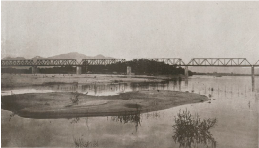
Pont sur le song Tra Khuc, composé de 11 travées métalliques standard de 50 mètres.
