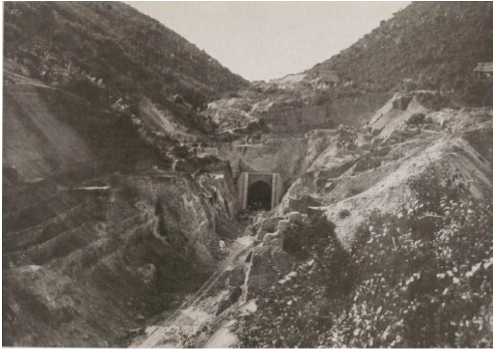
La tunnel de Thi-Thanh (325 mètres).
