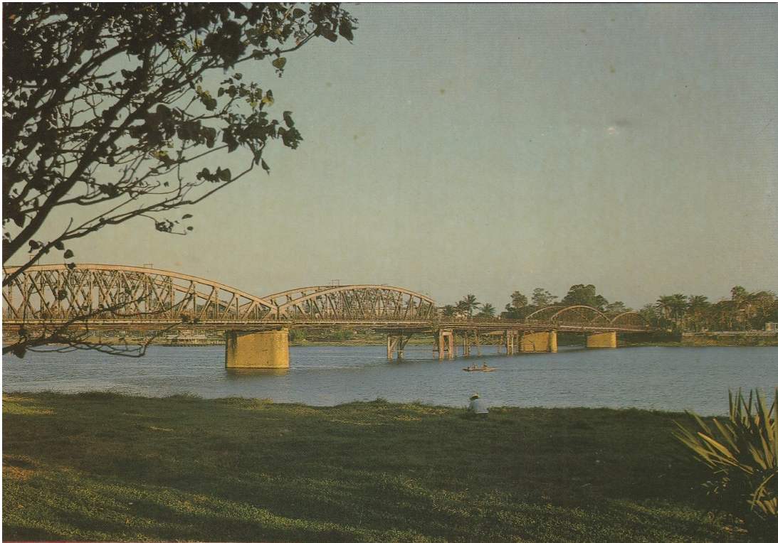
Huế. — Pont Trang Tiên (anciennement pont Thanh-Thai, puis Clemenceau)(Photo Vu Vinh) L'arche centrale a disparu et des piles provisoires soutiennent le tablier.
