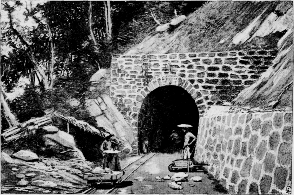
Entrée de tunnel à Cai-lai-brousse
