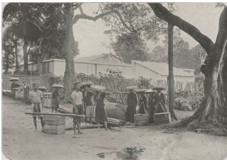
Entrepôt de pétrole à Hatinh
