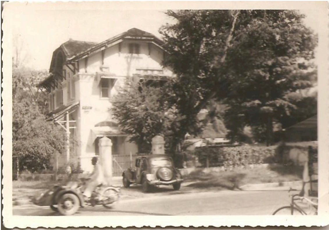
Maison des Dubourg, 87, rue Richaud. Style typique de l'entre-deux-guerres : pignons cassés en façade et sur les côtés, aisseliers pour soutenir les toits en avancée, persiennes, auvents en tuiles... Devant : la Citroën Traction avant de fonction
