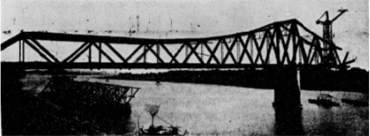
5. — Construction de la console du pont du Bassac.
