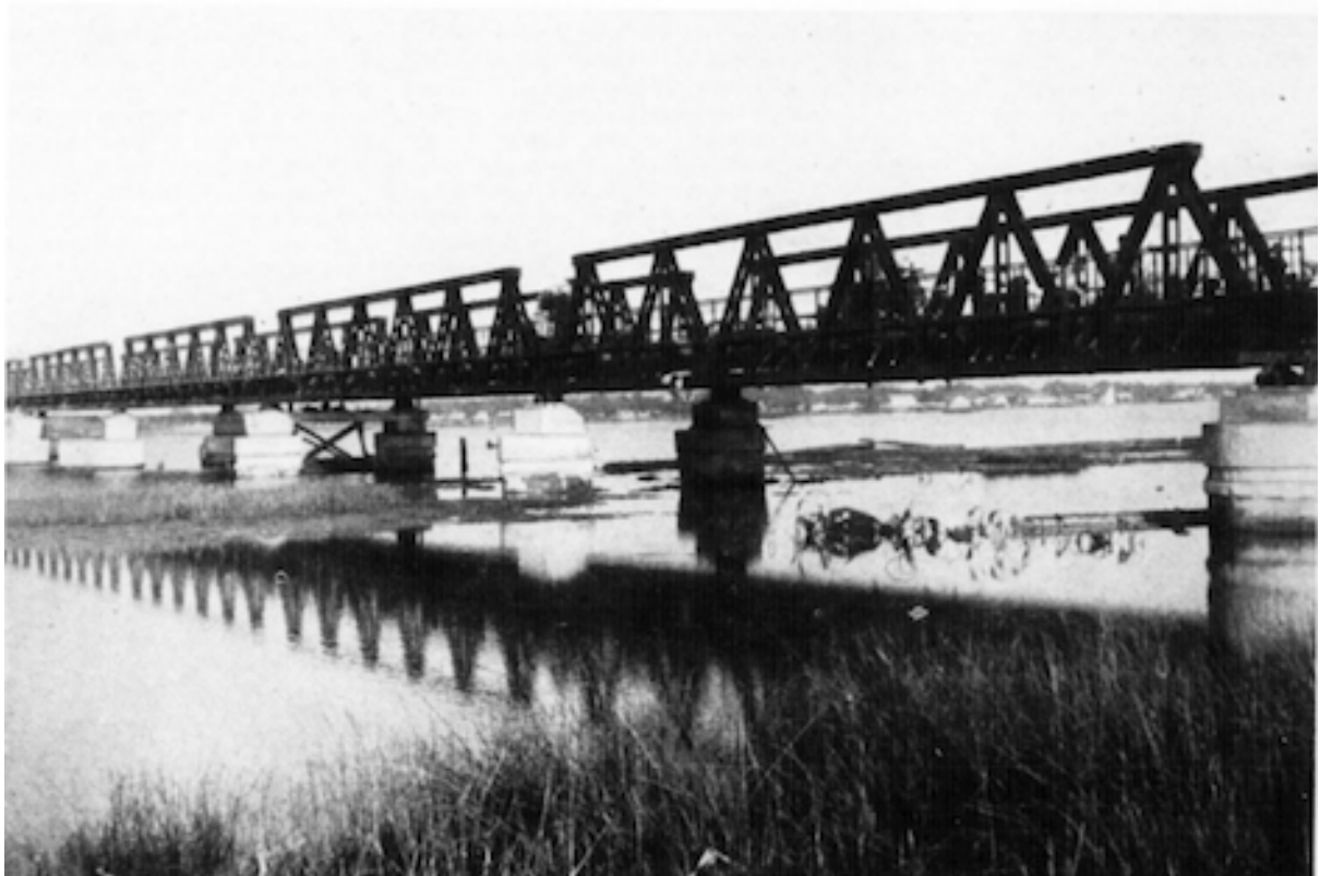
Plus de 100 km de ponts exécutés en Indochine dont le pont Maréchal-de-Lattre-de-Tassigny, sur le bras de mer de Tourane, d'une ouverture totale de 517 m., achevé en février 1952
