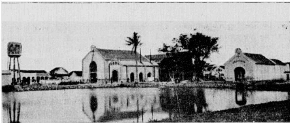
La centrale électrique de Thanh-Hoa, vue générale
