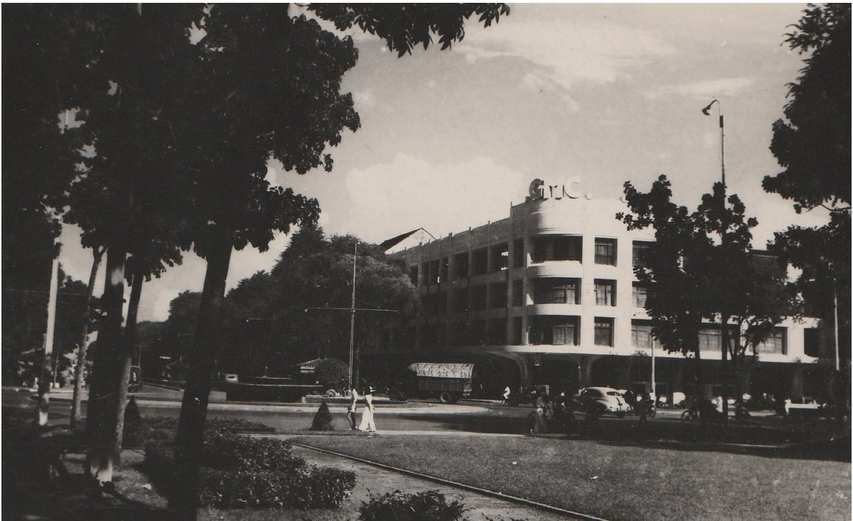
Les Grands Magasins Charner surélevés d'un étage.
