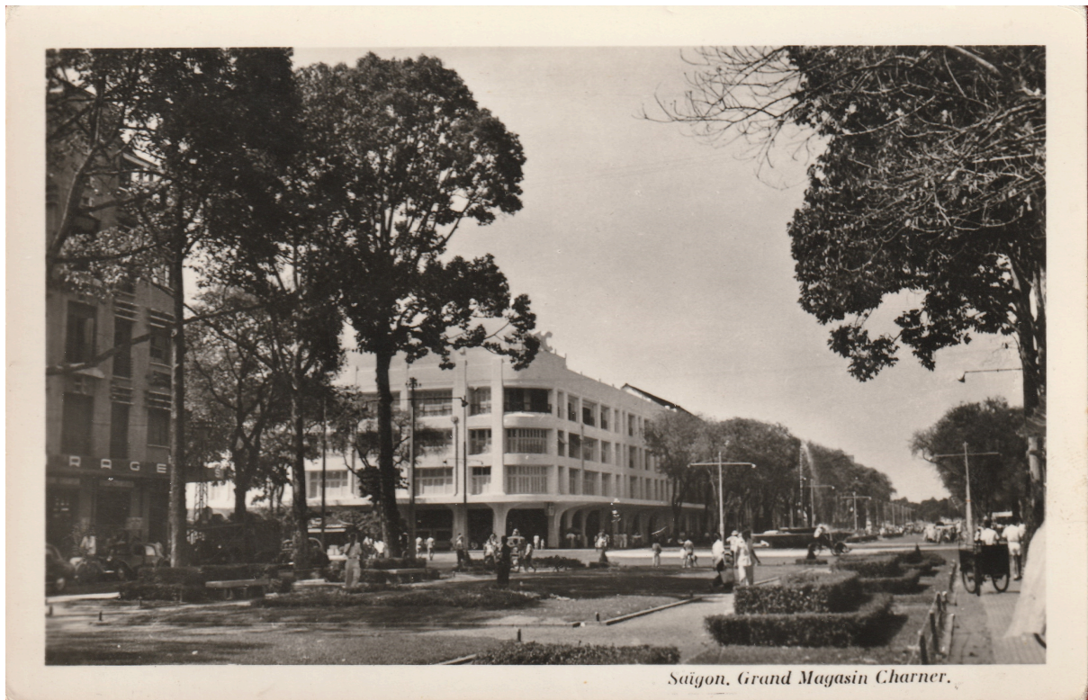
SAIGON. — Les Grands Magasins Charner surélevés d'un étage (Photo Nam-Phat, Saïgon)
