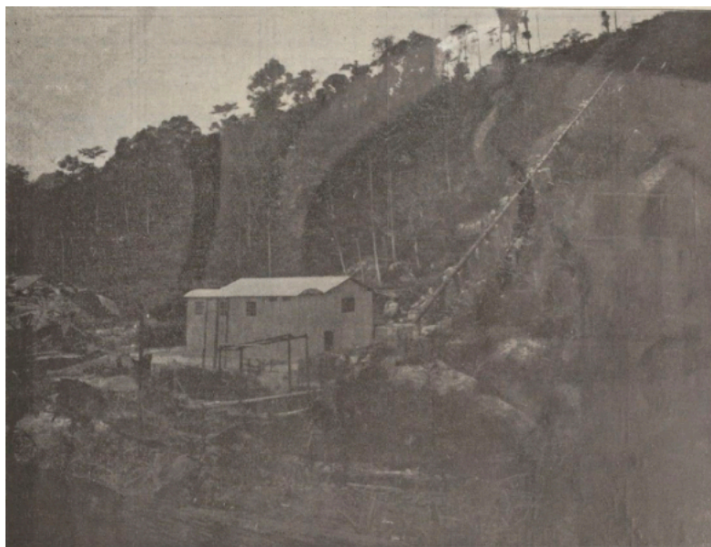
Fig. 1. — Vue générale de la Centrale d'Ulu Guroh.
