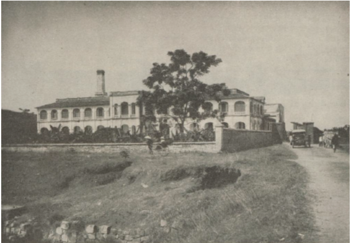
Vue générale de la papeterie de Dap-Cau
