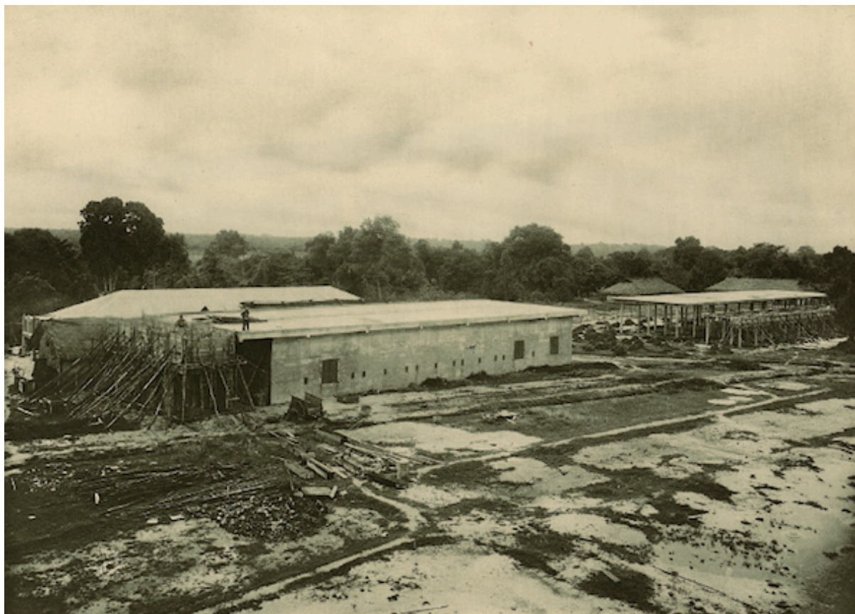
Planche 110. — Vue d'ensemble des bâtiments en béton armé. Au premier plan, bâtiment devant servir de fumoir.
