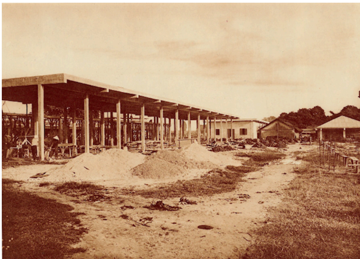
Planche 108. — Bâtiment en béton armé pour le logement des bâtiments indigènes.
