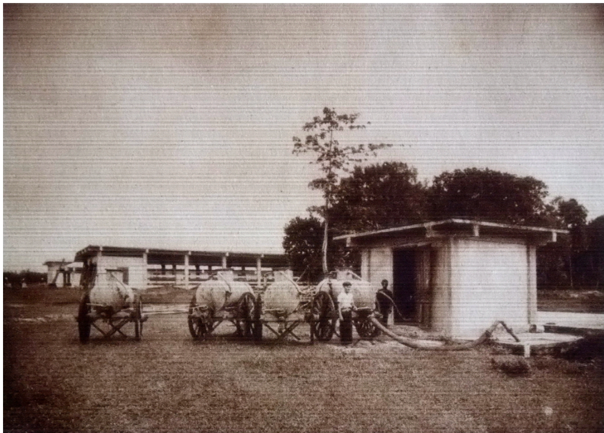
Pompage par le vide
