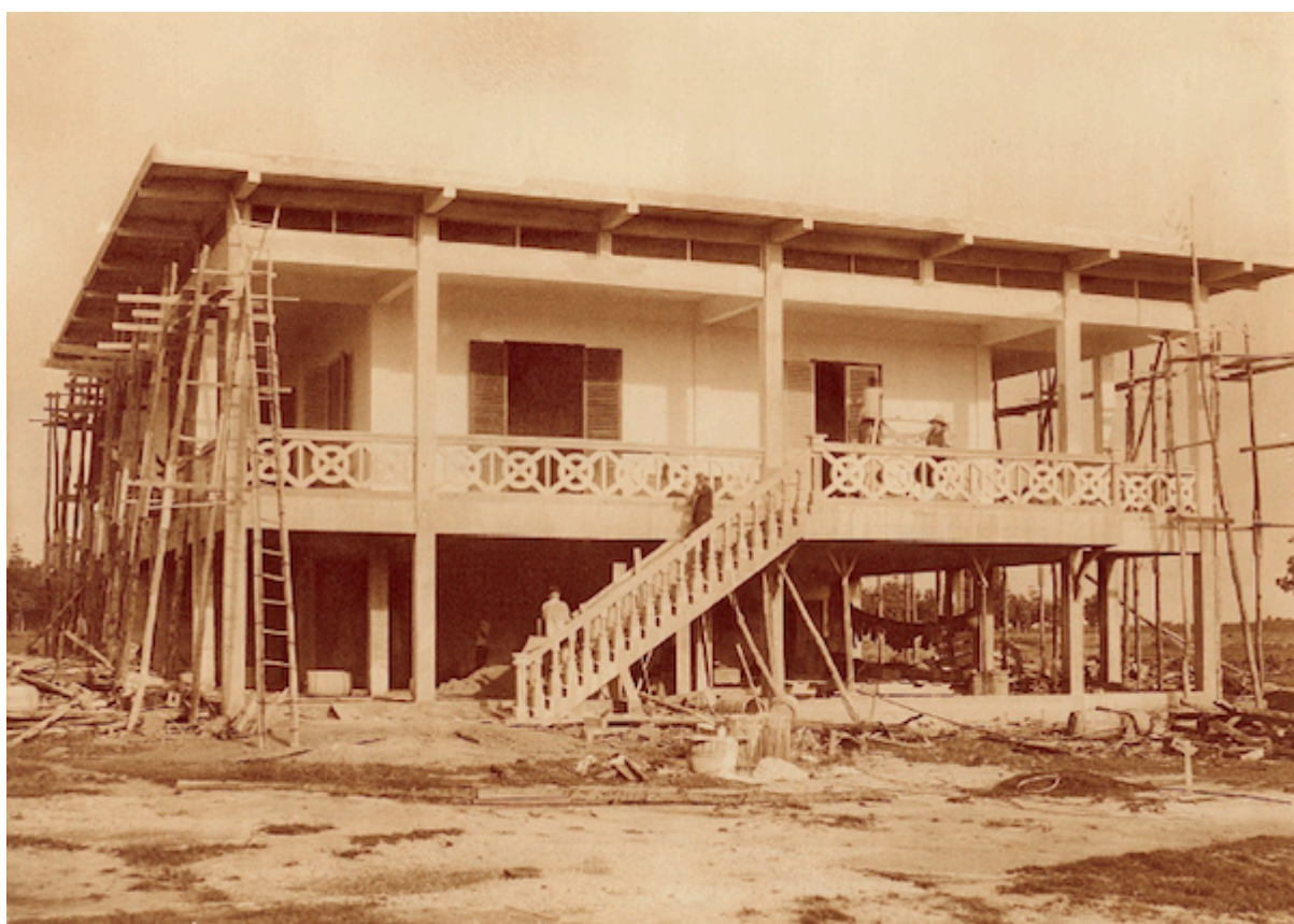
Planche 109. — Bâtiment en béton armé pour le logement du directeur de la plantation.
