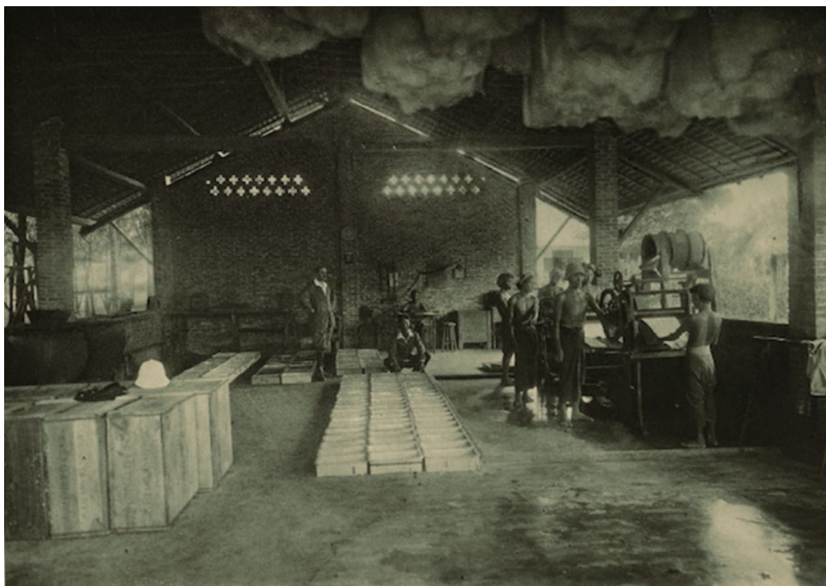
Planche 164. — Vue intérieure de l'usine
