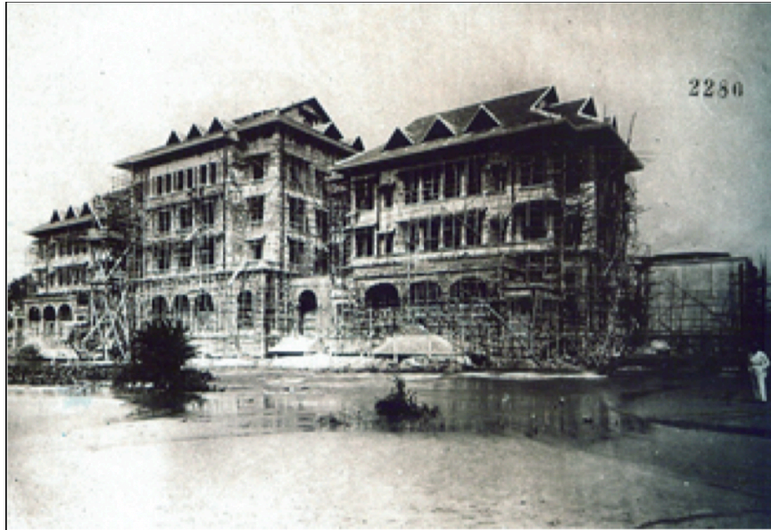
1928 : l'hôtel en construction
