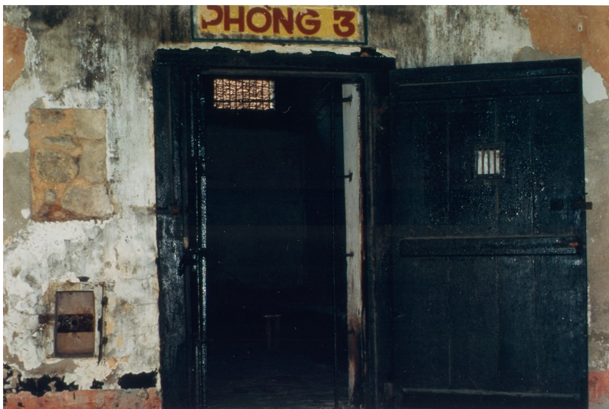
Entrée d'une cellule ayant connu une évacuation par le toit (1)
