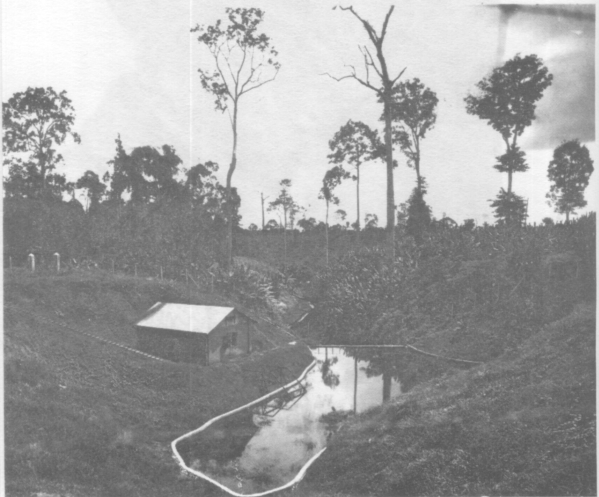
Anloc - Station de pompage - Août 1939
