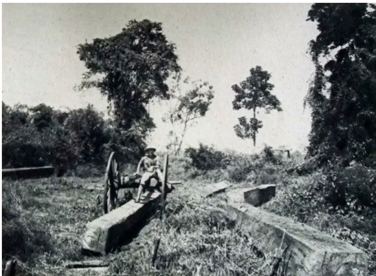
Après l'abattage de la forêt, transport du bois de construction (Pl. 60)
