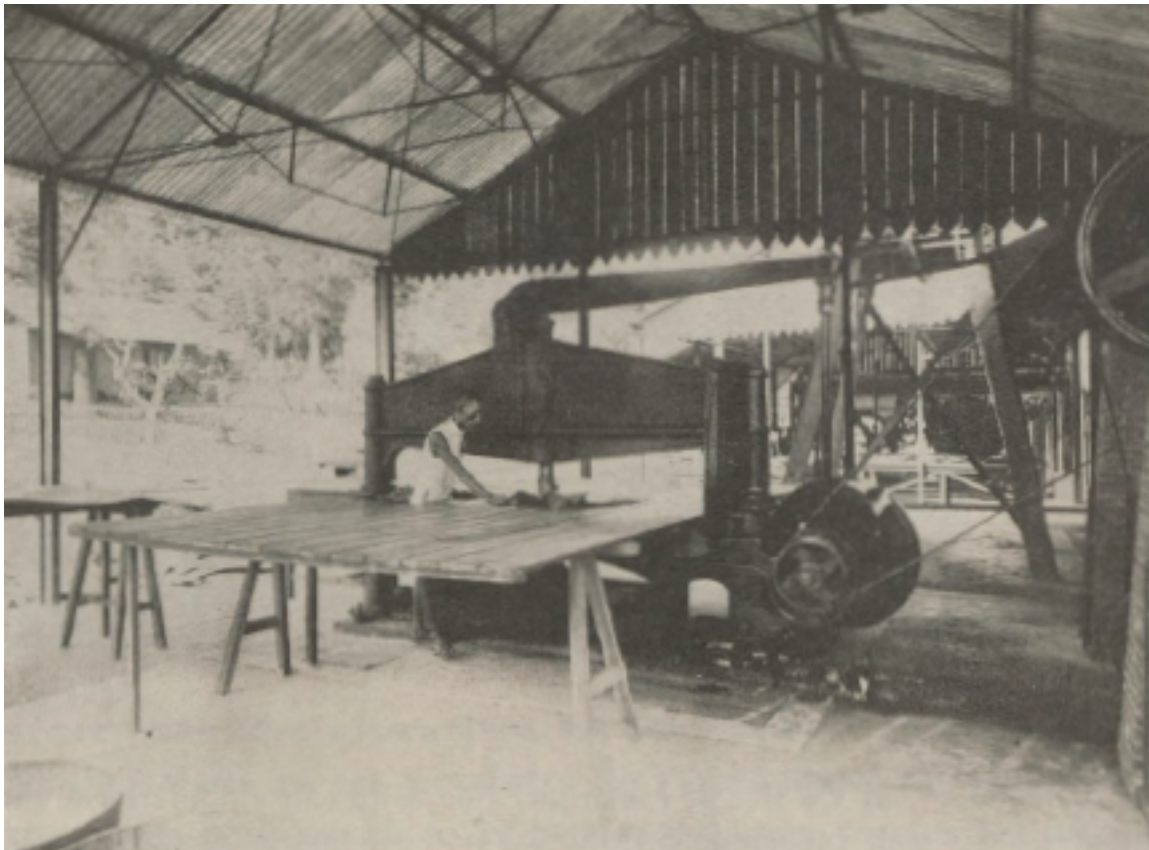
Machine à battre. 140 coups à la minute. Pression : 5.000 kg.
