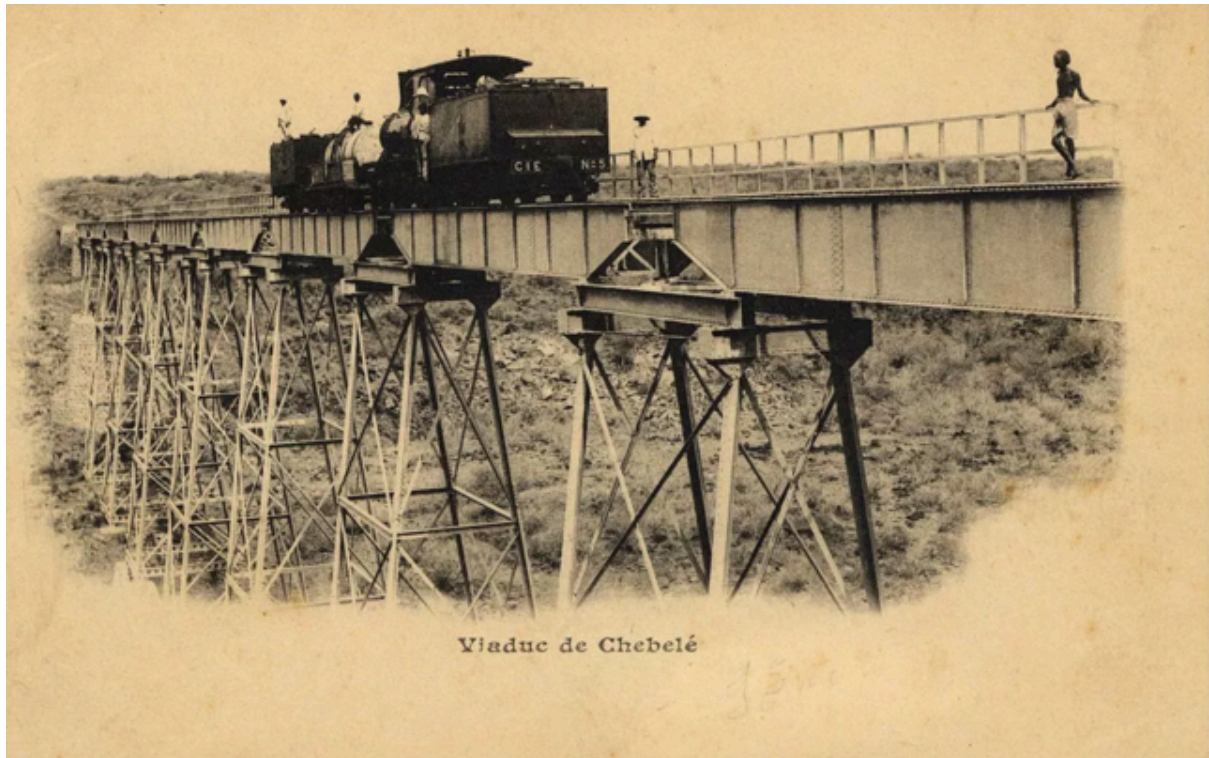
Viaduc du Chebelé
