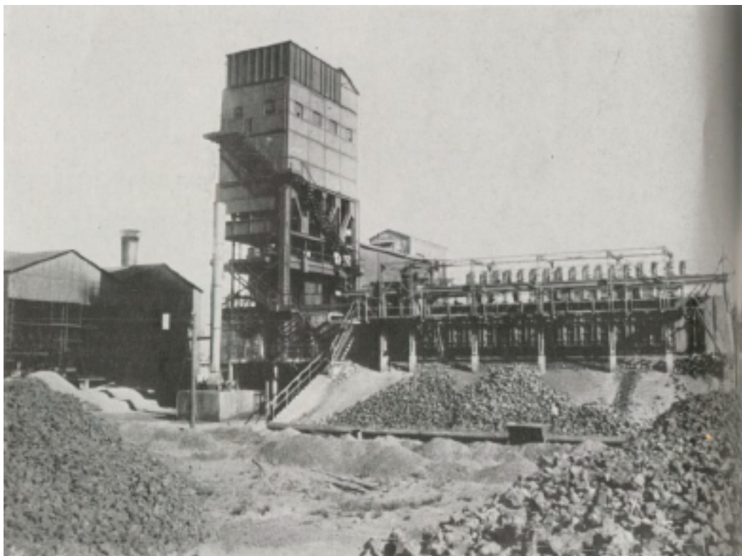
Cokerie à Nouméa
