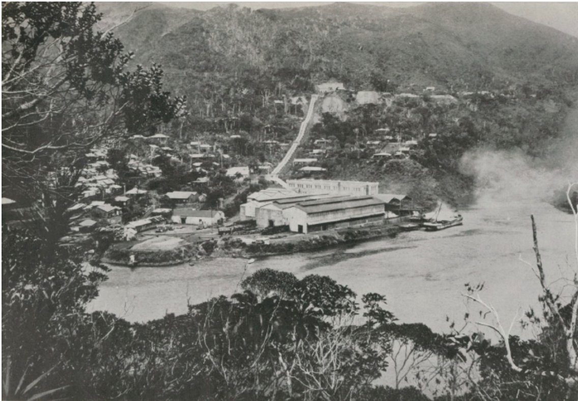
Usine hydroélectrique de Yaté
