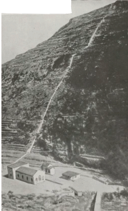
La conduite forcée et les bâtiments de la centrale : deux groupes turbine Pelton, alternateur.
