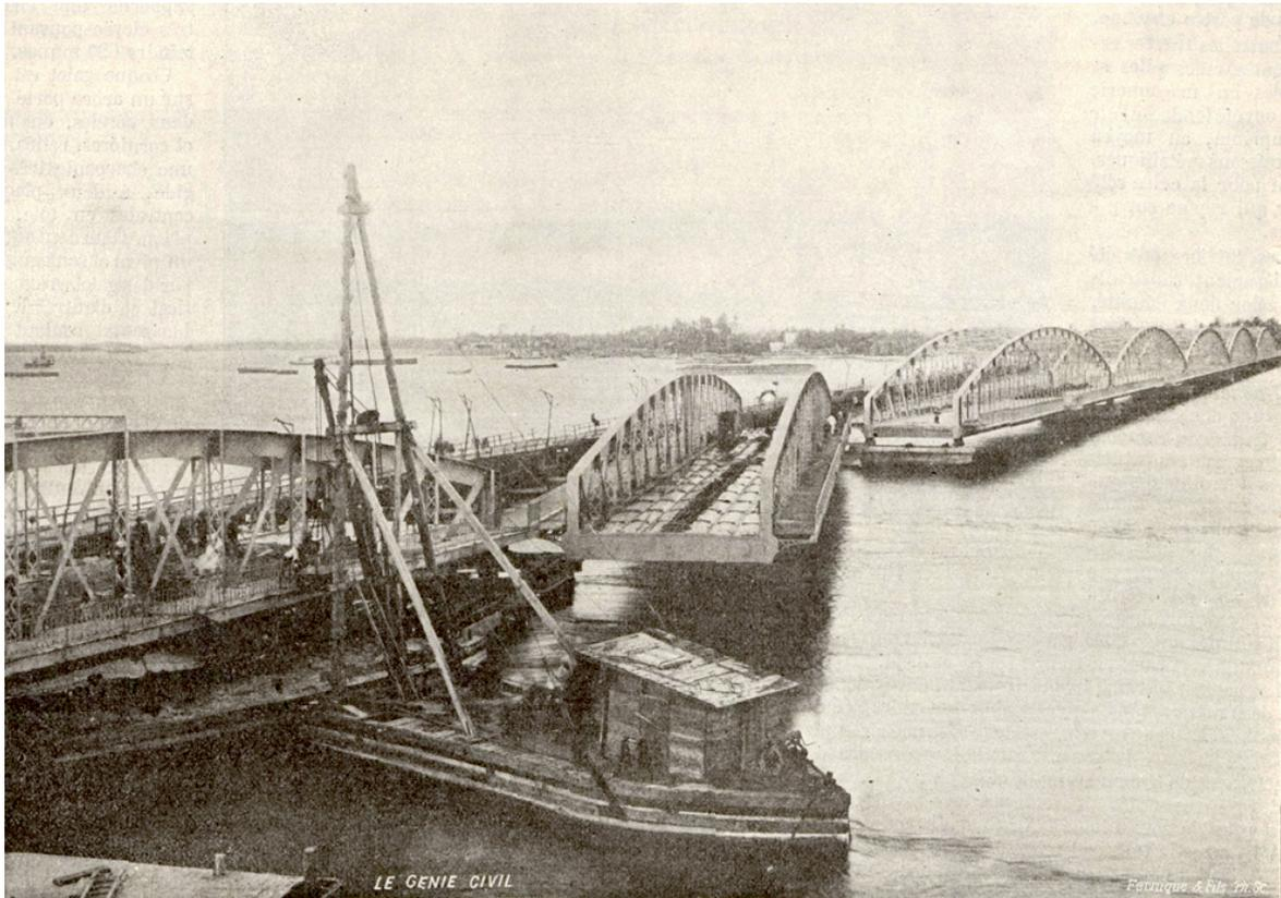
FIG. 1. — LE NOUVEAU PONT FAIDHERBE : Vue générale, prise du côté Saint-Louis, avant l'achèvement de la chaussée du pont tournant.
