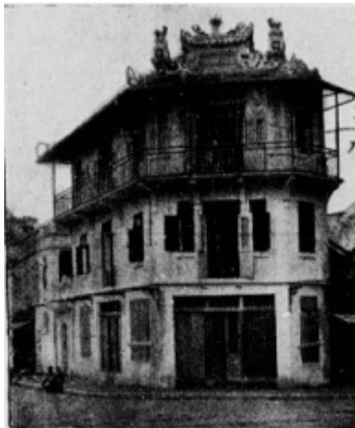
Maison en construction à Hanoï, rue du Cuivre
