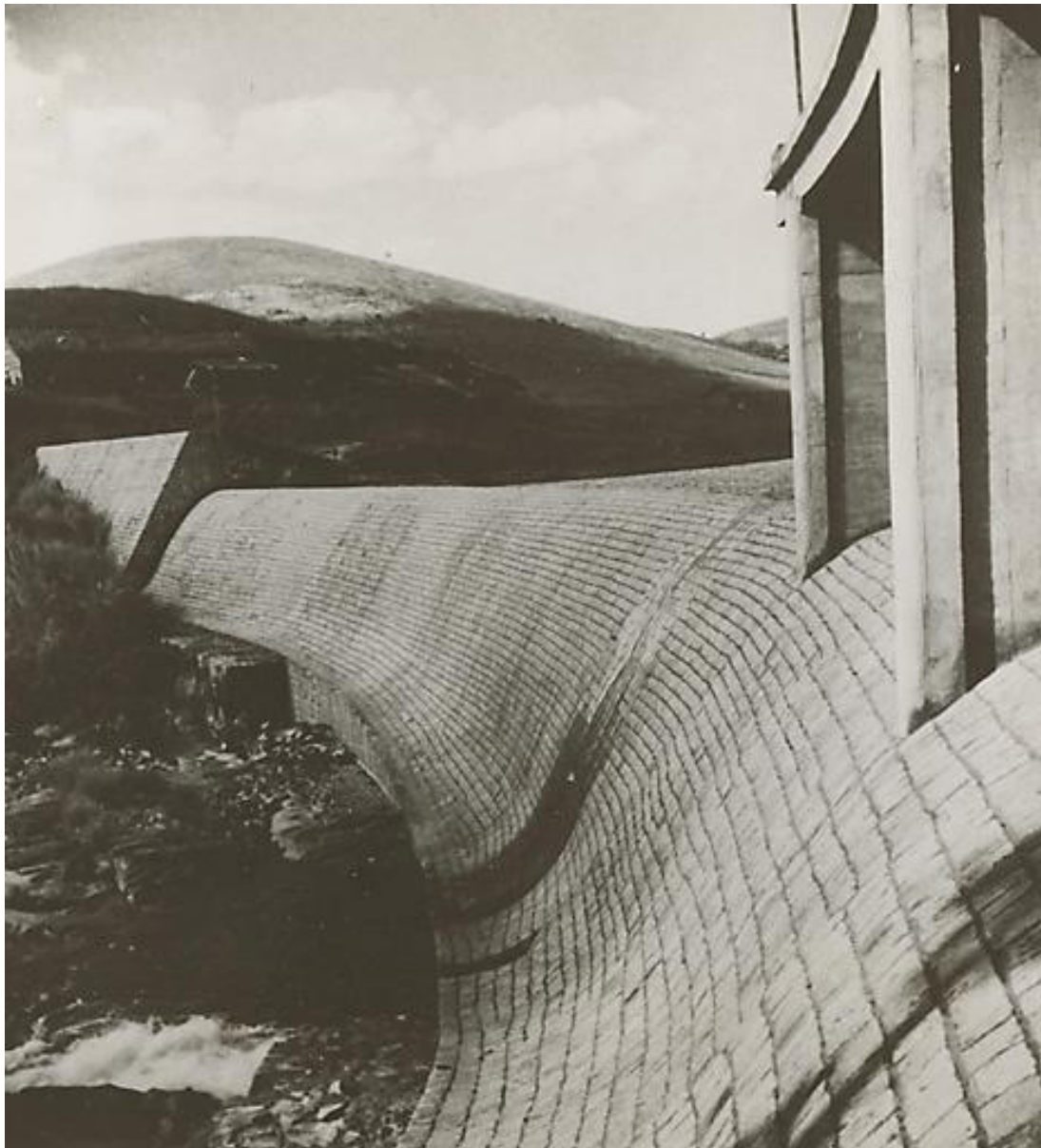
Barrage d'Ankroet (ANOM). Construit en pierres de taille extraites à proximité et avec un minimum de béton, pénurie et difficultés de transport obligent.
