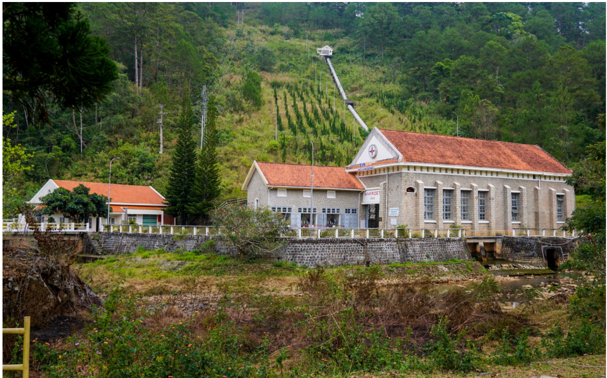
L'usine hydro-électrique. Photo Tri Thuc & Cuộc Sông La capacité a été portée de 600 à 3.100 kW en 1960, puis à 4.400 kW.
