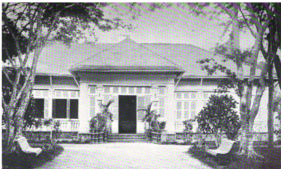
Inspection de Gò-công
