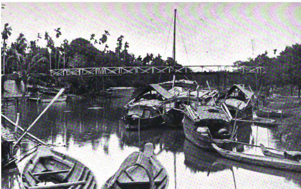
Pont de Cày-lậy
