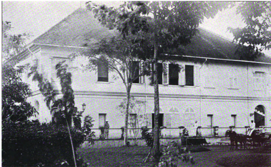
Bureaux de l'Administration à Bà-rịa
