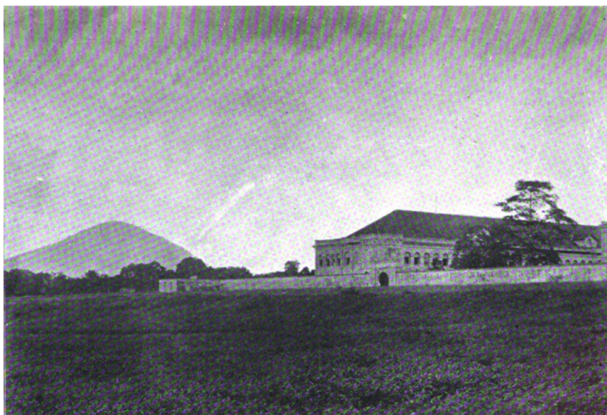
Façade du fort de Tây-ninh et montagne Bà-đen
