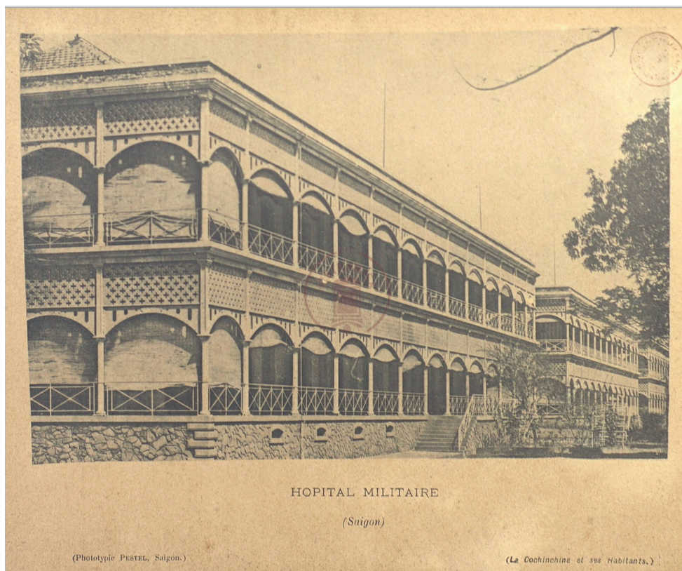
Hôpital militaire [futur Hôpital Grall], rue La-Grandière
