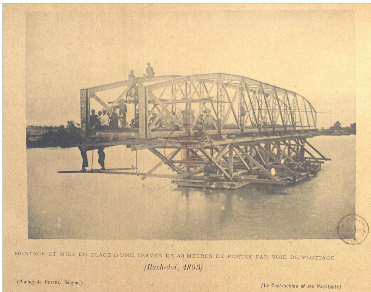
Montage et mise en place d'une travée de 40 mètres de portée par voie de flottage (Rach-doi, 1893)
